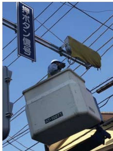
県内でも数少ない 既設の道路への信号設置
